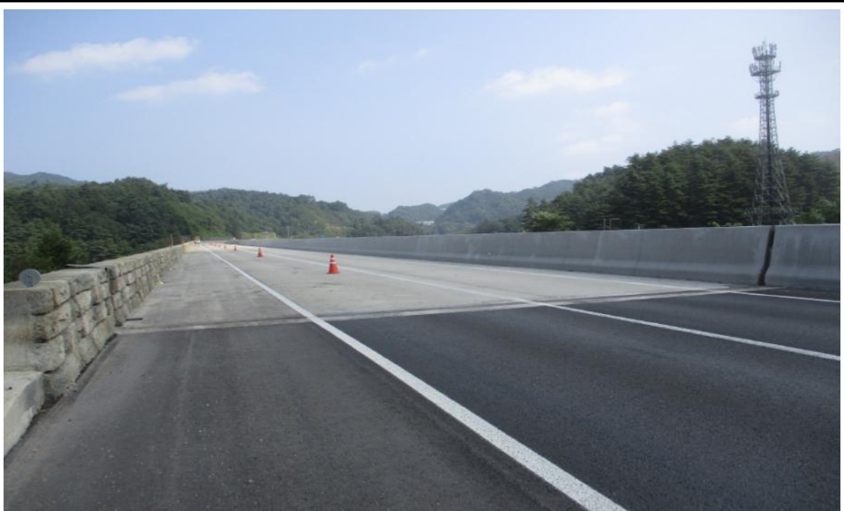
교량 상부 전경
